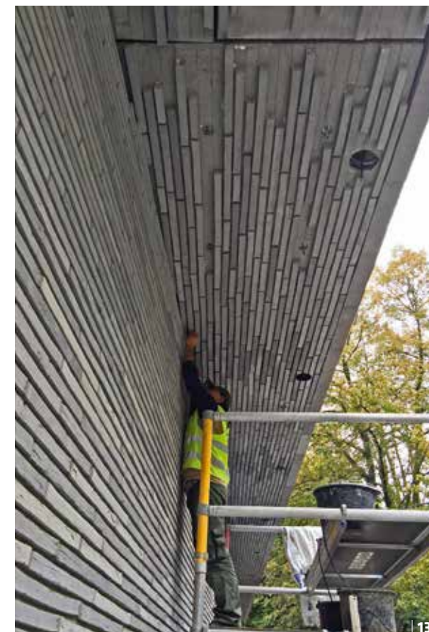
13, 14 | Montaż elementów ceglanej elewacji z ręcznie formowanych cegieł o charakterystycznym, podłużnym kształcie (Petersen Kolumba) 15 | Elewacja od strony ogrodu 16, 17 | Wyjście na taras z lobby windowego na trzecim piętrze – stalowa konstrukcja oraz szklane balustrady 18, 19 | Wielkoformatowe okna z żebrowanymi szklanymi o wysokości około 3 m
