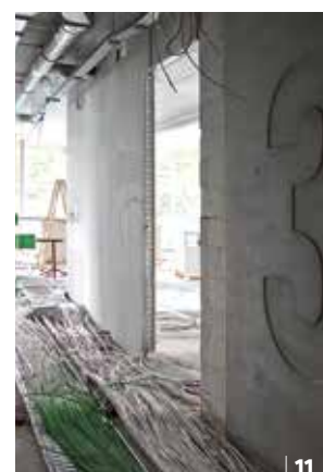
6 | Żelbetowa konstrukcja budynku 7, 9 | Fasada od strony dziedzińca 8 | Mock-up (próbki) malowania pionowych żaluzji fasady – elementy będą miały specjalny kolorowy nadruk, nawiązujący do logo firmy Ericpol 10 | Betonowanie orurowania stropów termoaktywnych TABS 11 | Montaż okablowania strukturalnego 12 | Przeszkłone ściany sali konferencyjnej zlokalizowanej w holu na pierwszym piętrze
