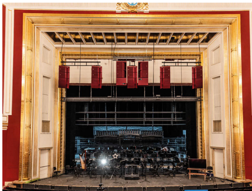
Fot. 4. Zaawansowany system dźwięku immersyjnego składa się m.in. z siedmiu gron głośnikowych frontowych. Zdjęcie zrealizowane w trakcie procedury strojenia akustycznego sali.
