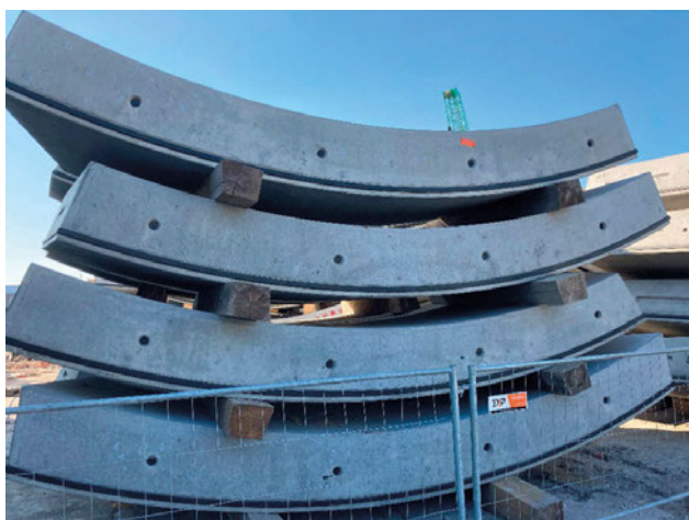
Rys. 5. Cztery segmenty, czyli połowa jednego pierścienia obudowy tunelu kolejowego w Łodzi, o średnicy 12,7 m – widoczne obwodowe uszczelki na każdym segmentcie
