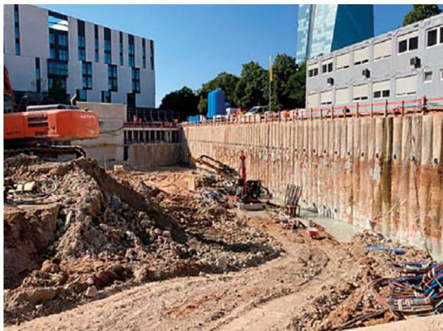
We Frankfurcie nasi koledzy z Keller Grundbau wykonali projekt, w ramach którego roboty geotechniczne zostały zrealizowane w sposób neutralny pod względem emisji.
