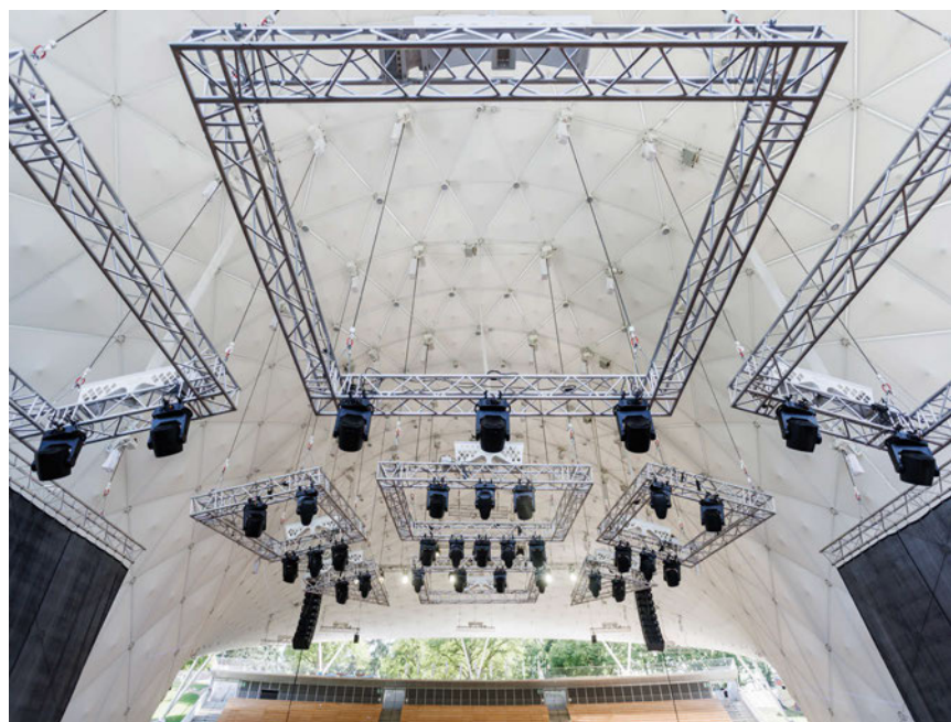
Fot. 2. W konstrukcji dachu zaimplementowano bogaty system górnej mechaniki scenicznej, umożliwiający swobodne podwieszanie systemów scenicznych: oświetlenia, nagłośnienia, projekcji, dekoracji.
