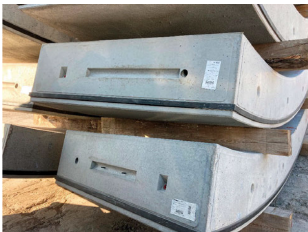
Rys. 6. Pojedyncze segmenty obudowy tunelu w Łodzi – widoczne otwory na trzpienie, dyble oraz na pręt prowadzący
