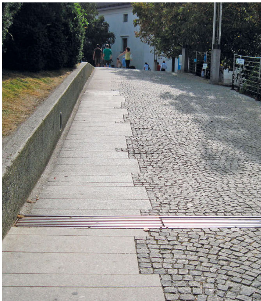
Przykład ciągu pieszego, w którym zastosowano wielkogabarytowe płyty cięte z kamienia naturalnego, ułatwiające poruszanie się po nich osobom ze szczególnymi potrzebami
